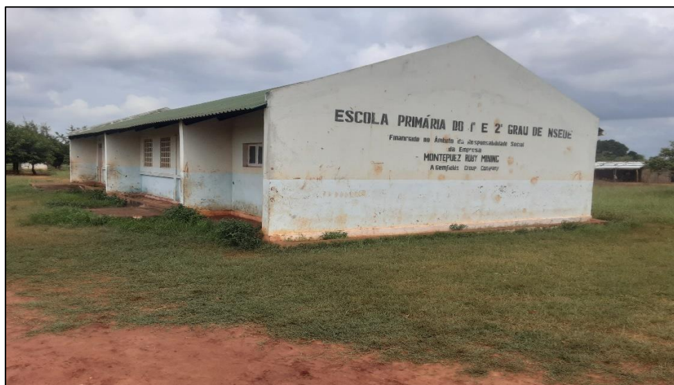
Figura 7-8 Escola Primária de 1 e 2 grau de Nseue, no povoado de Nseue
