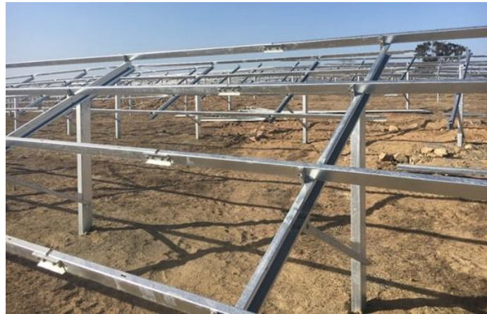
Figura 4-3 Sistema Típico de Estrutura de Montagem Fixa
